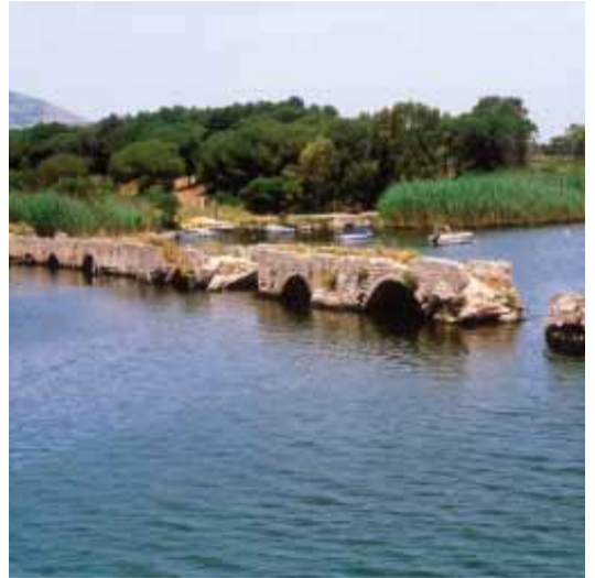
Reste einer römischen Brücke, Sardinien
